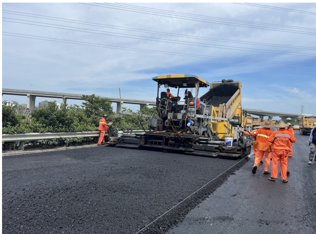
工人正在给公路做沥青摊铺。 通讯员 陈子昂摄
