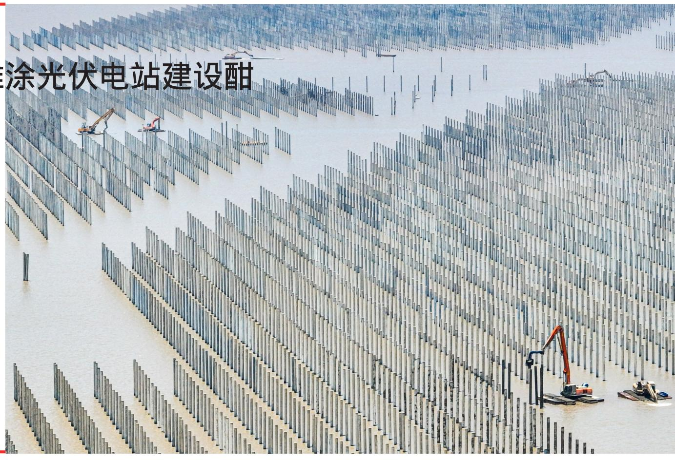
近日，温岭市东部松门渔光互补光伏电站项目建设现场，施工人员各就其位进行管桩吊运、滩涂拖桩、定位打桩等工序，现场一派繁忙景象。
