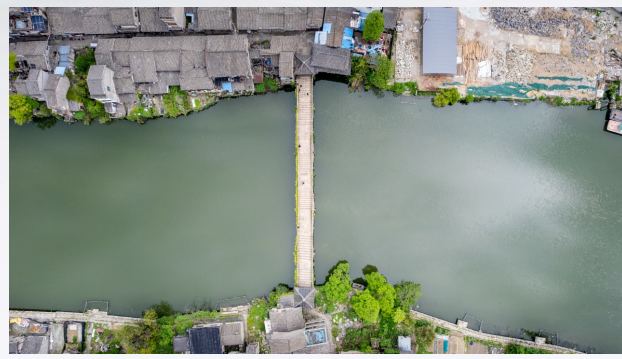
航拍下的寺前桥。
