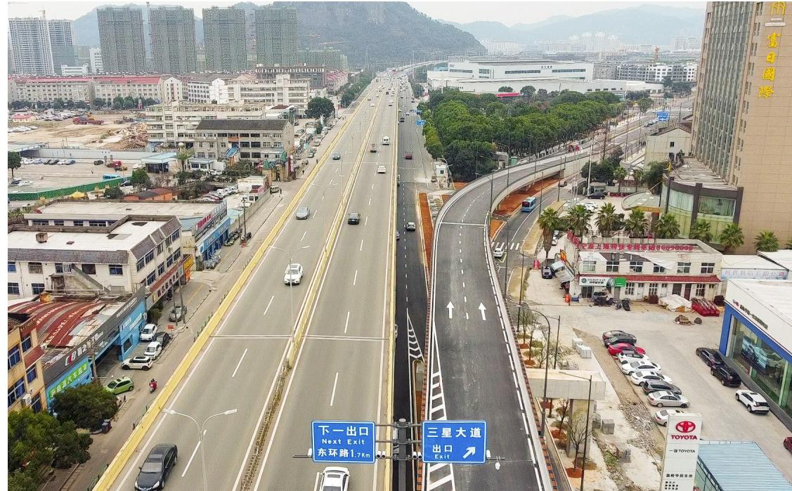
今日通车。工程起点位于下保路，终点为锦屏路，路线全长约 1730 米，通过 白改黑 加高，改造为双向六车道，同时对地下管线、绿化等进行改造。
