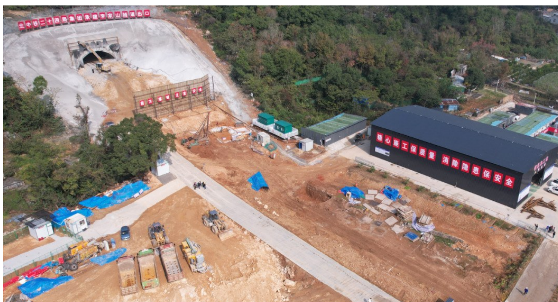
温玉铁路李家山隧道出口爆破现场。
