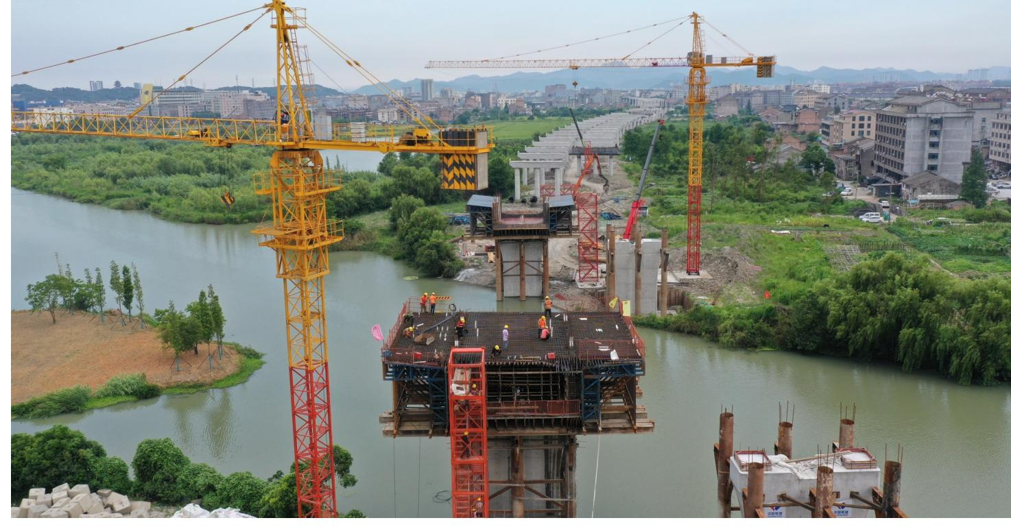
本报讯（记者刘振清 通讯员王丙文/图）7月9日凌晨，历经10个小时的连夜通宵浇筑，随着最后一车混凝土的倒入，甬台温高速至沿海高速温岭联络线泽国一号高架桥左幅四号墩零号块顺利完成浇筑，这是温岭联络线一分部浇筑完成的首个零号块。零号块浇筑完成，标志着该段桥梁上部结构
