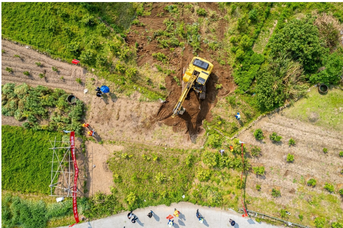
工作人员正驾驶大型机械对地表植被开展清表作业。
