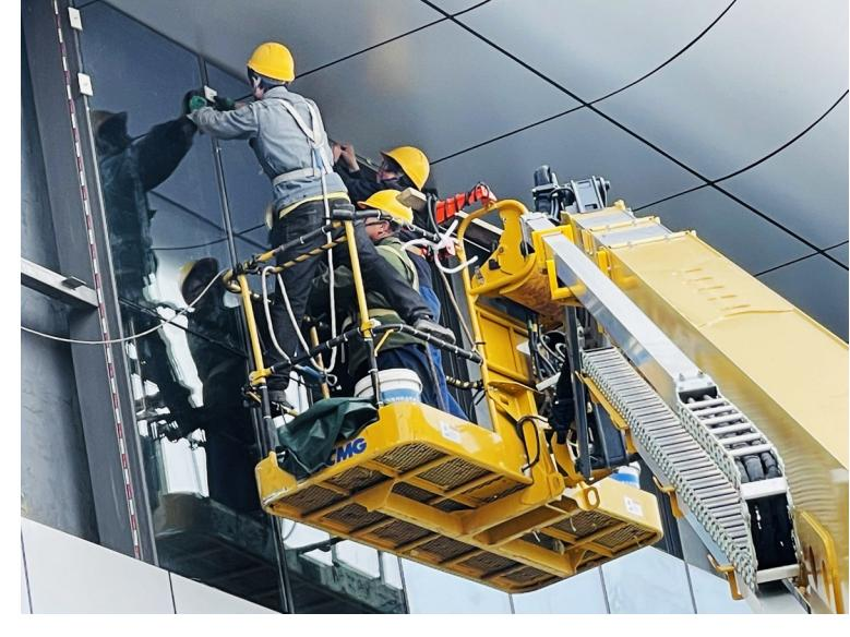
近日，台州市域铁路S1线横峰高架站的建设者争分夺秒，加速站房的新型玻璃幕墙安装和内部装饰，迎接6月30日S1线一期工程全线试运行。图为建设者正在安装降低太阳辐射的新型玻璃幕墙。
