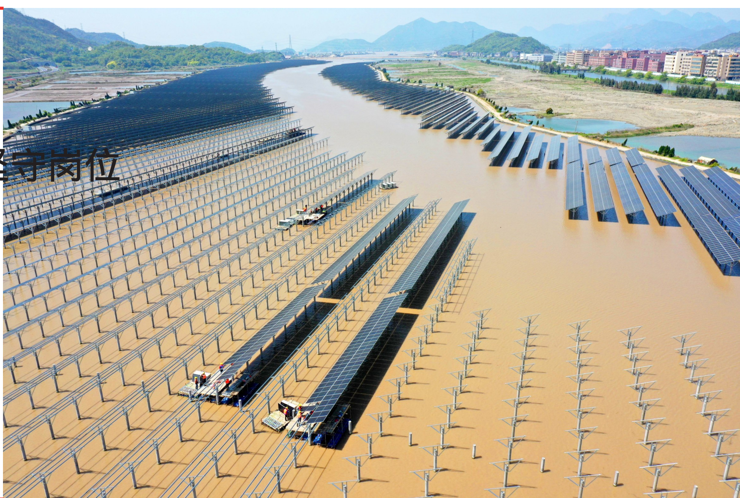
4月4日,江夏潮汐试验电站库区,为确保工程在5月底建成并实现全容量并网,建设者放弃小长假休息时间,加班加点在水上安装潮光互补智能光伏发电场太阳能板和支架。
