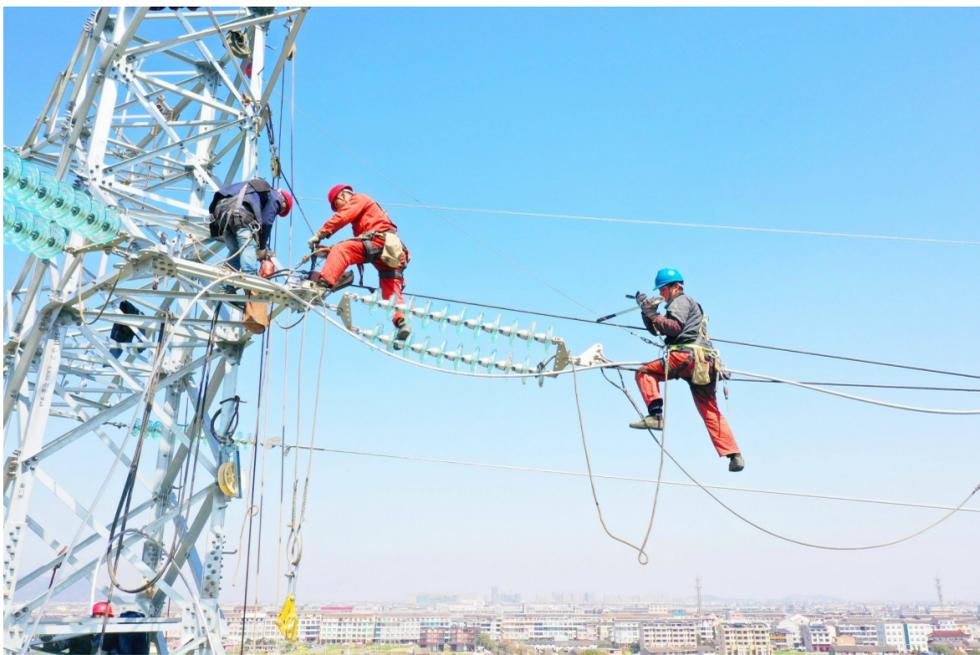
3月8日，箬横镇浦东村，电力工人在台州沙角110千伏输电线路最后一座转角塔上架设线路，并将于近日完成全线线路架设。
