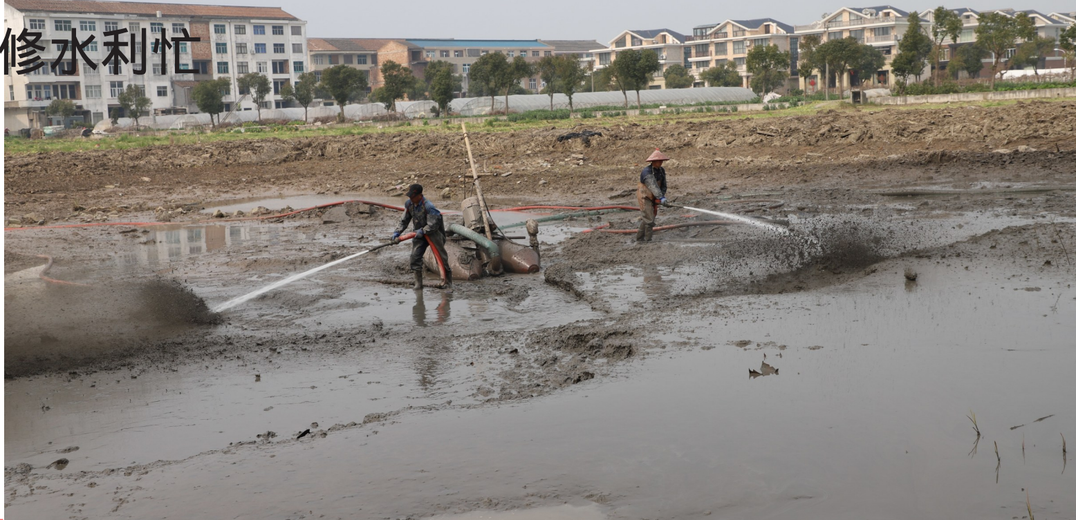
眼下正是春修水利的好时节，3月1日上午，位于松门镇乃岙村的一处小微水体，机声隆隆，两名施工人员用高压水枪认真冲洗池塘淤泥，边上两台漂浮式浮筒泥浆泵强力吸取着冲刷出来的淤泥，施工现场一派忙碌。 通讯员 江文辉摄
