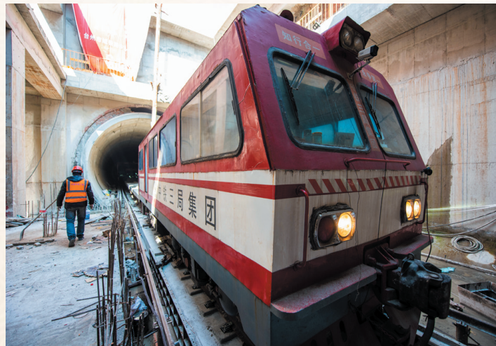
一列运送铁路铺轨材料的列车抵达施工现场，为每天铺轨作业提供物资保障。
