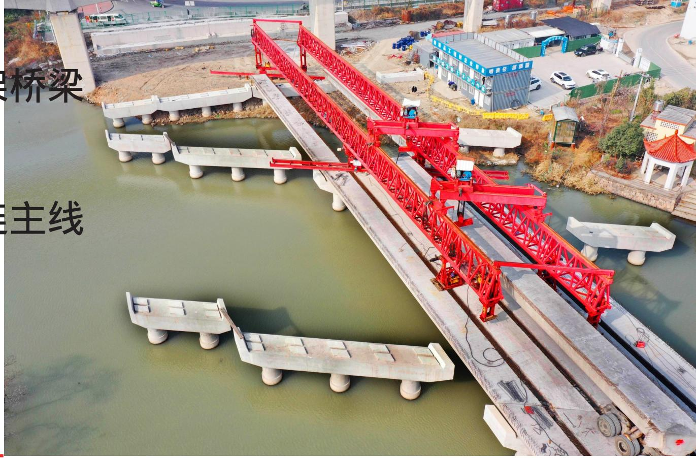
1月13日，疏港公路与横峰大道连接线跨桐山溪桥施工现场，架桥机正在架设桥梁。
