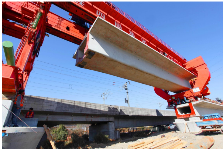
2020年1月13日，杭台高铁与甬台温铁路温岭站北端下行联络线特大桥最后一扣箱梁顺利架设。
