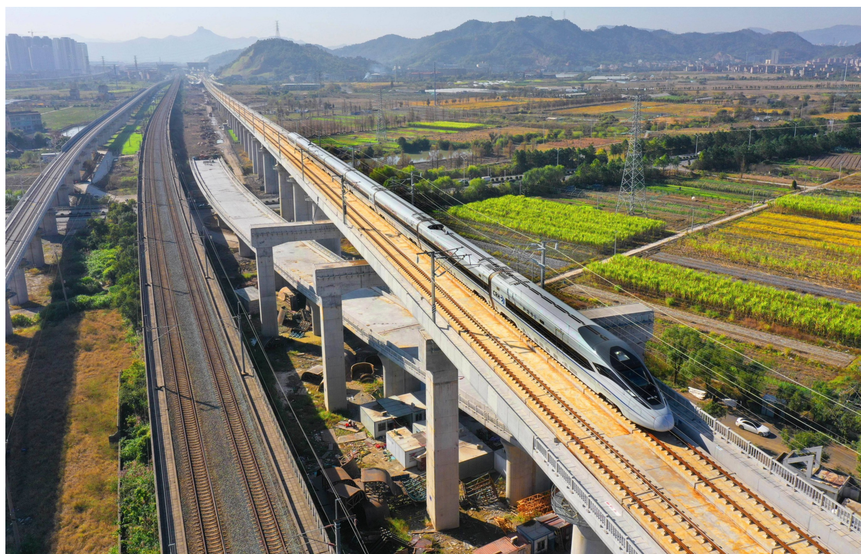
2021年11月26日上午，一列高速列车行驶在杭台高铁泽国特大桥上，这是杭台高铁首趟试运行列车。
