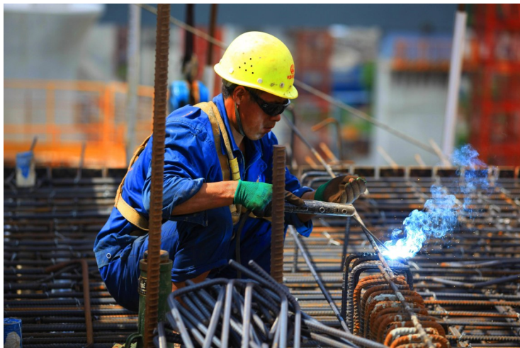
2019年12月15日，一名工人在焊接桥墩钢筋。
