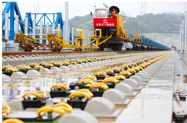
2021年6月20日，铺轨车从路桥进入温岭界，标志着杭台高铁温岭段开始铺轨作业。
