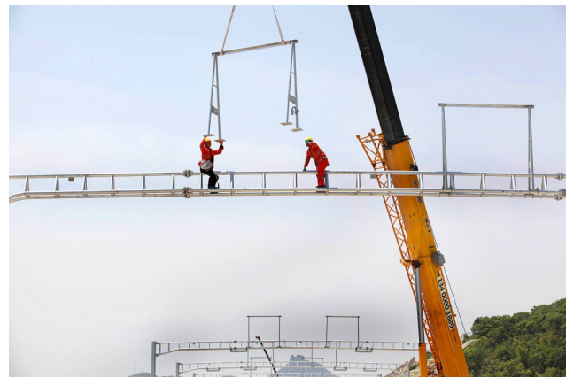
2021年5月1日，杭台高铁温岭站南端站场施工现场，工人正在忙着安装电气化接触网主梁架。
