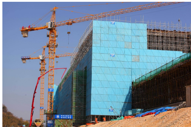
2021年2月5日上午，随着最后一方混凝土浇筑完成，杭台高铁温岭站站房主体结构正式封顶。
