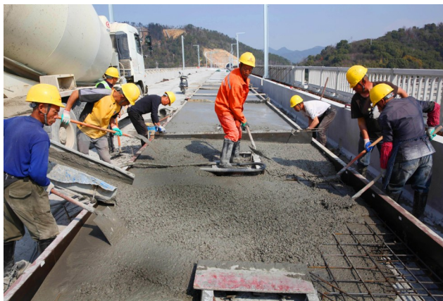
2021年2月15日，农历正月初四，工人放弃春节休息时间加班浇筑无砟轨道底座板混凝土。
