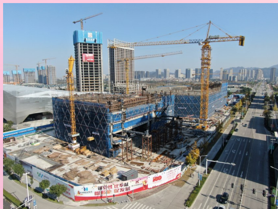
建设中的文化中心项目。
