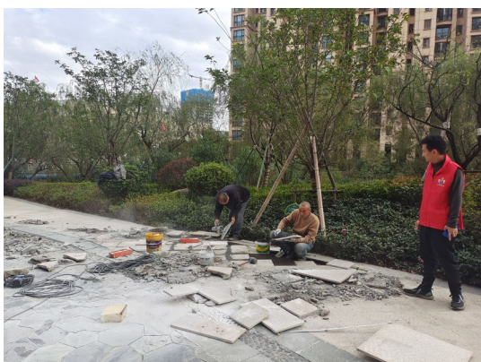
业委会监督施工方确保施工进度和质量。
