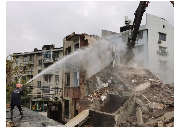
11月29日,太平街道对G228建设征用房屋进行拆除。整个拆除过程使用高压水枪除尘,机械作业到哪里,高压水枪就射到哪里,最大程度减少拆屋过程中产生的尘土对周边居民带来的影响。
