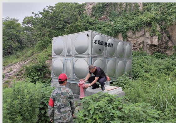
林业工作人员对基础设施进行日常巡护。
