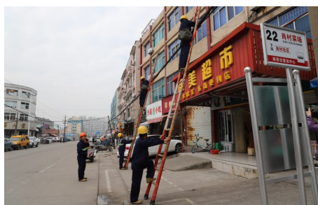
施工人员对管线进行整理捆扎。
