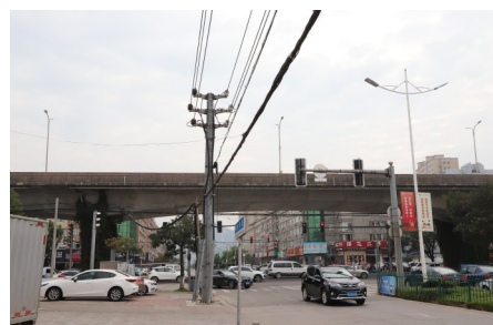
曙光东路和锦屏大道交叉路口，经过整治后的空中管线看上去有序多了。
