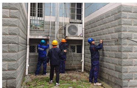
施工人员在小区内清理废线，对分散的线路进行整理捆扎。
