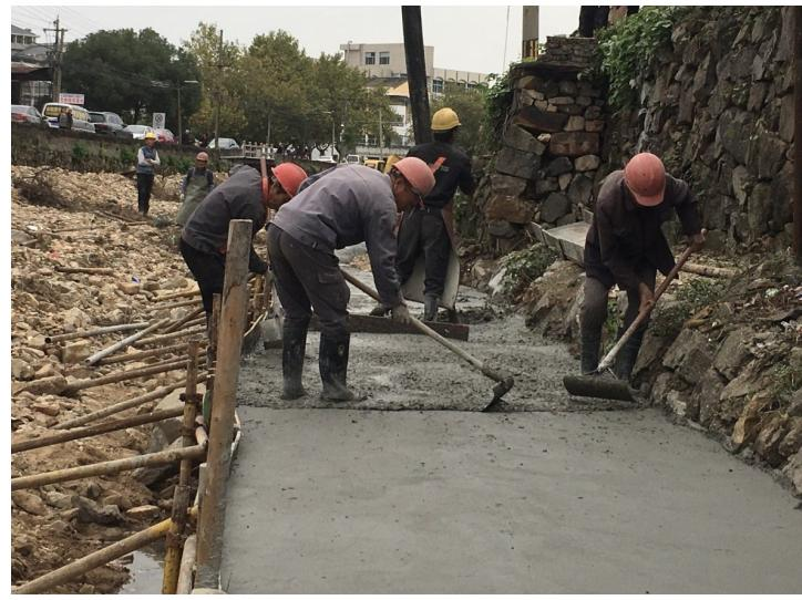
10月24日,伴随着一辆辆混凝土搅拌车的进出,前溪太平街道小南门段混凝土护岸堤基脚开始浇筑。浇筑好的护岸堤基脚既可以起到护堤作用,又能为周边群众提供休闲散步好去处。
