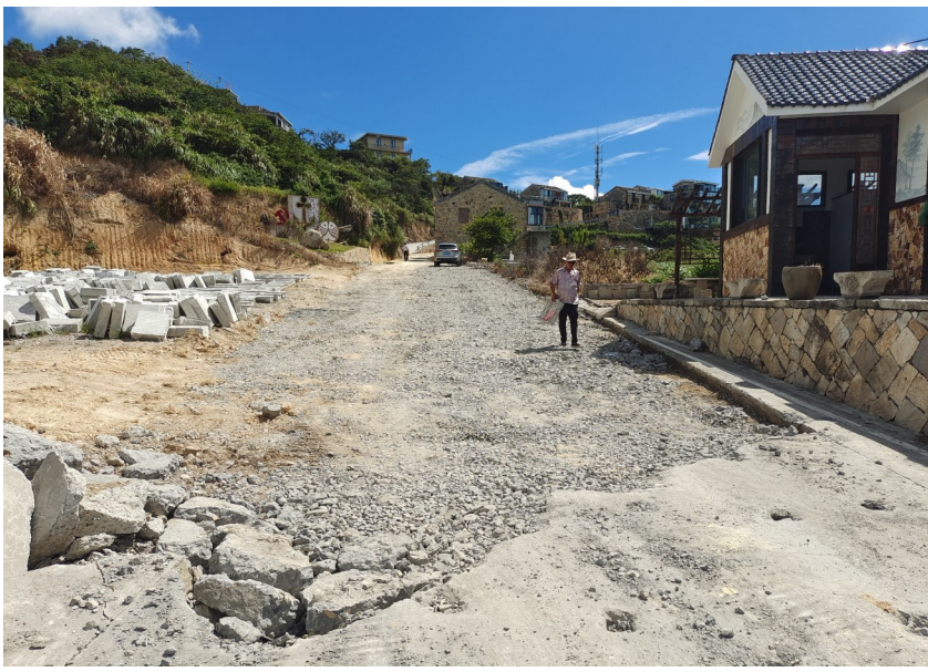
原来的水泥混凝土路面已经被挖开。
