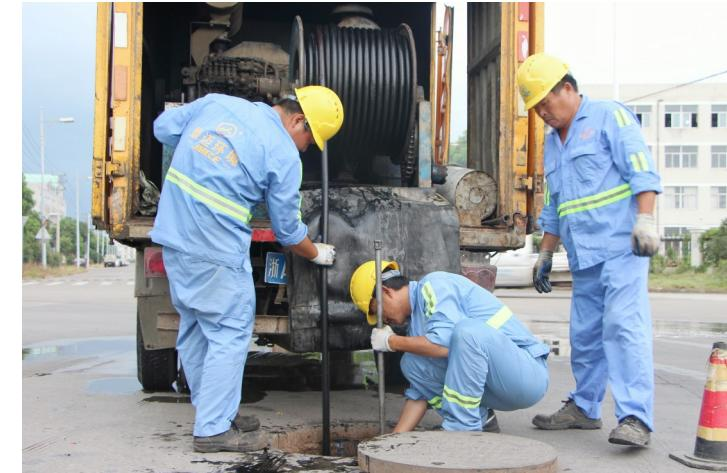
近日，箬横镇汽摩配工业园区主干道上，浙江景迈环境工程有限公司的员工们趁着河网水位低，对该镇61公里地下污水管网开展养护运维，确保城镇排水管网经脉通畅。
