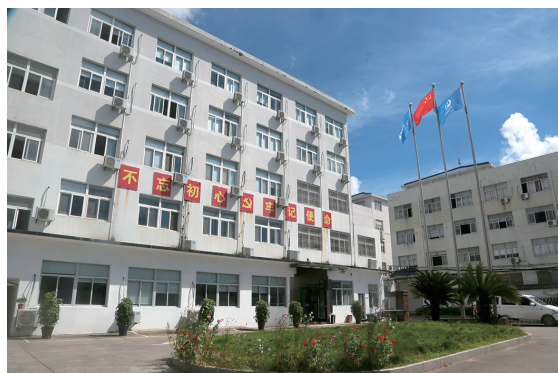
中铁三局集团项目经理部办公处。
