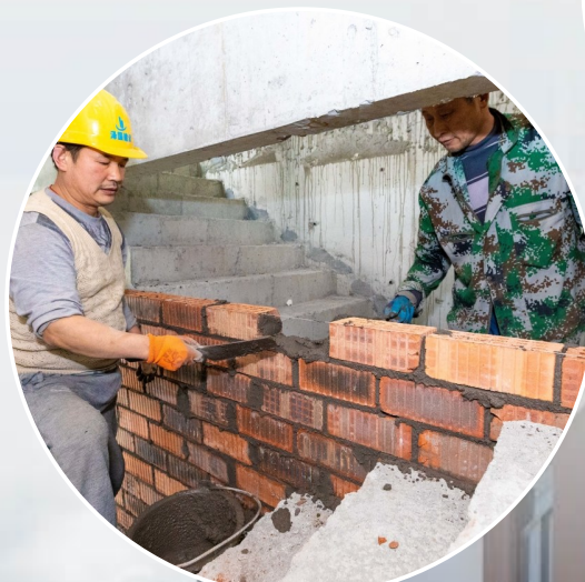
坊下街改造工作中，施工者有条不紊地开展作业。
