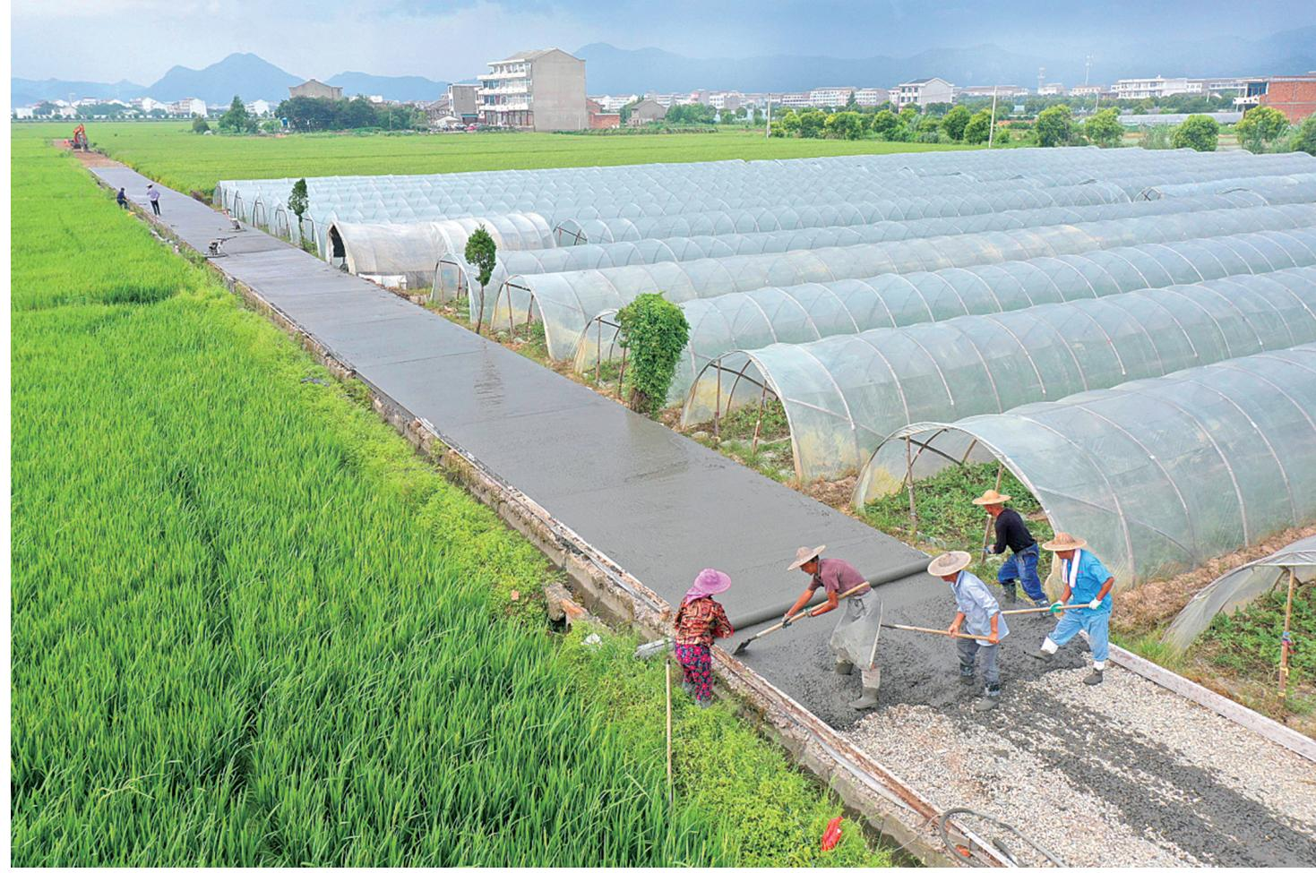
近日,箬横镇岁坊村一片水稻田和西瓜地中间,数位农民工在浇筑水泥路面,硬化田间机耕路。
