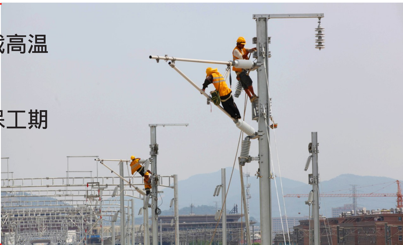
7月11日，三伏入伏，温岭火车站南端杭台高速铁路主线延长线，工人冒着高温酷暑，在高空安装吊旋、挽臂、瓷瓶等，与酷暑拼抢进度，确保按期按质完成施工任务。
