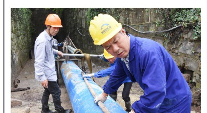
近日，在山下金水厂至城南供水管线工程施工现场，工人正在隧道内搬运安装钢管。该工程计划于6月底完工，投用后将极大缓解城南供水需求。目前，工程隧道喷浆435米已全部完工，绿化带钢筋混凝土挡墙施工已完成50%以上工程量，管桥和无负压泵站基础施工已完成。
