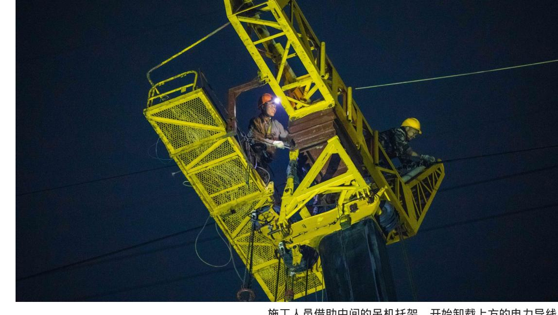
施工人员借助中间的吊机托架，开始卸载上方的电力导线。
