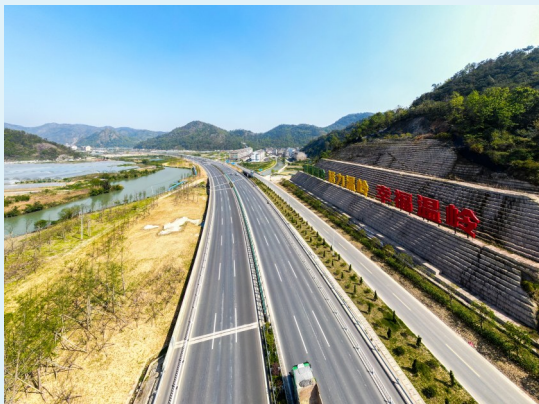
228国道(81省道)温岭段改建工程
