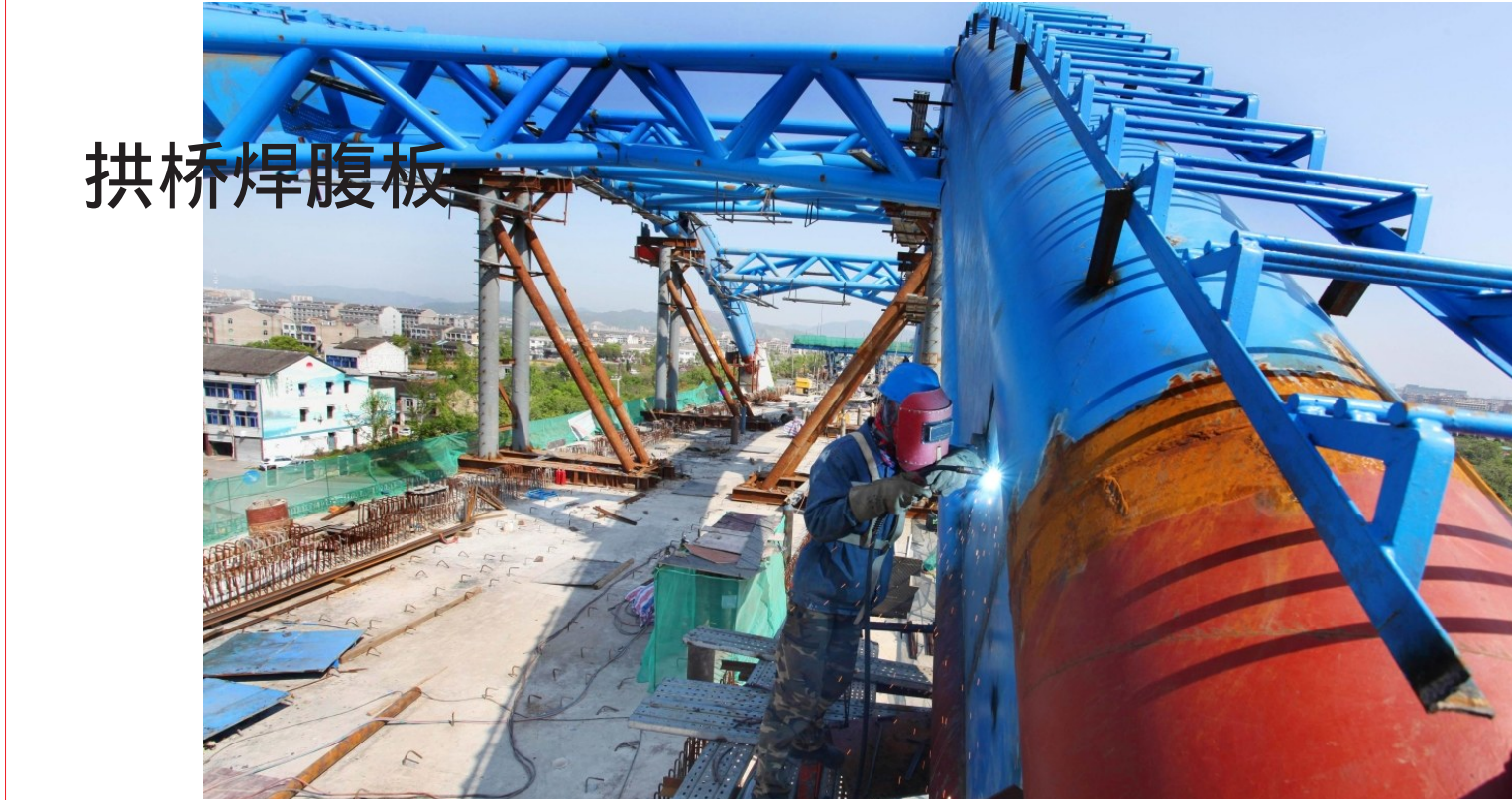
拱桥焊腹板 4月10日，台州市域铁路S1线温岭火车站特大桥，建设工人正在焊接拱桥最后的腹板，检测合格后进入灌注弦管管内混凝土等下道工序。温岭火车站特大桥跨越大石一级公路拱桥，是台州市域铁路S1线全线3座拱桥中第一座完成架设的拱桥。 记者 刘振清摄
