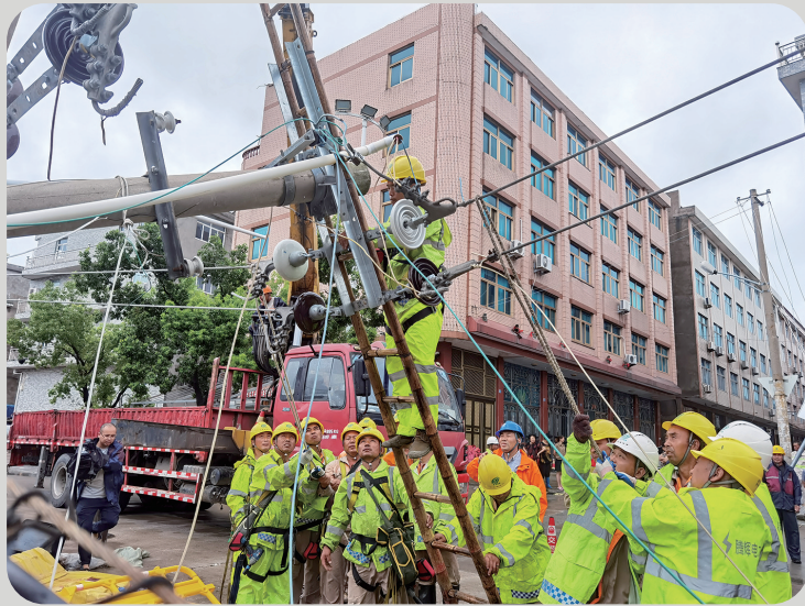
台风“黑格比”过境后，紧急修复受损电杆。
