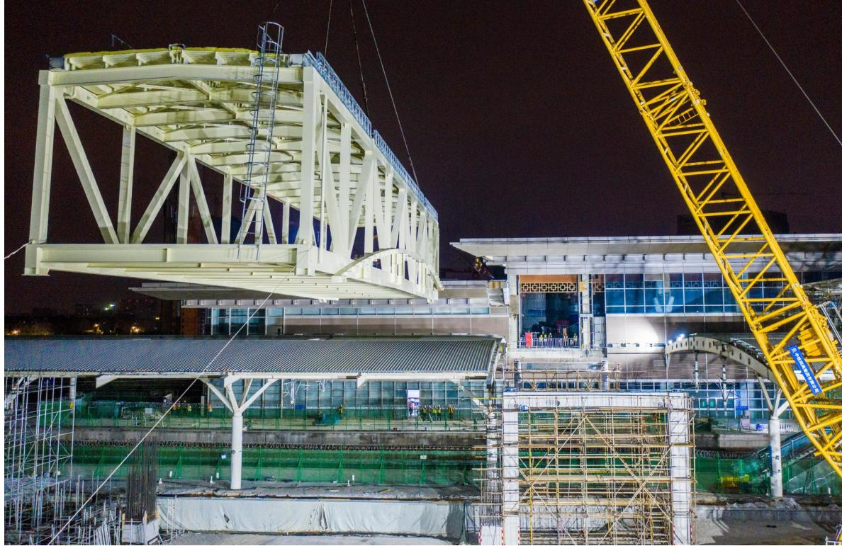
效率。同时，项目部狠抓过程控制，对钢结构天桥的施工工艺、质量、进度、安全、材料、人力等各个方面全方位盯控，有效保障首座天桥拼装和吊装任务的顺利完成，为后续施工提供坚实保障。
