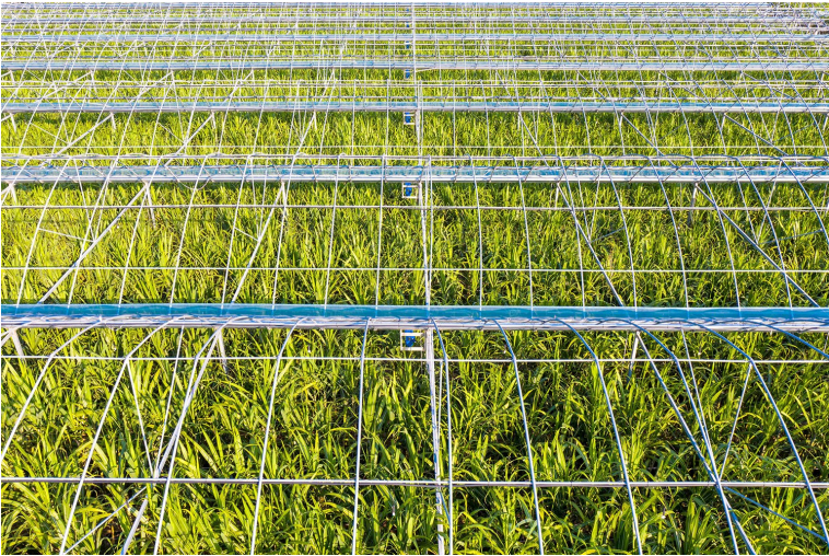
智能大棚高约6米，面积10亩，由自动升降机、卷膜机、喷水灌溉头、电机等组成。
