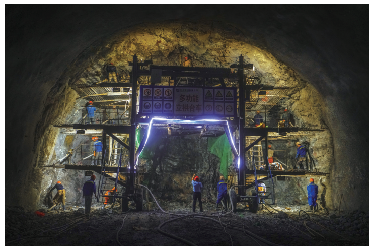
二等奖《隧道施工(组照之一)》赵国忠摄
