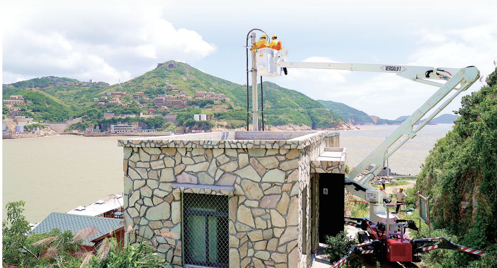
蜘蛛车 配网不停电作业。 本报记者 朱海伟摄
