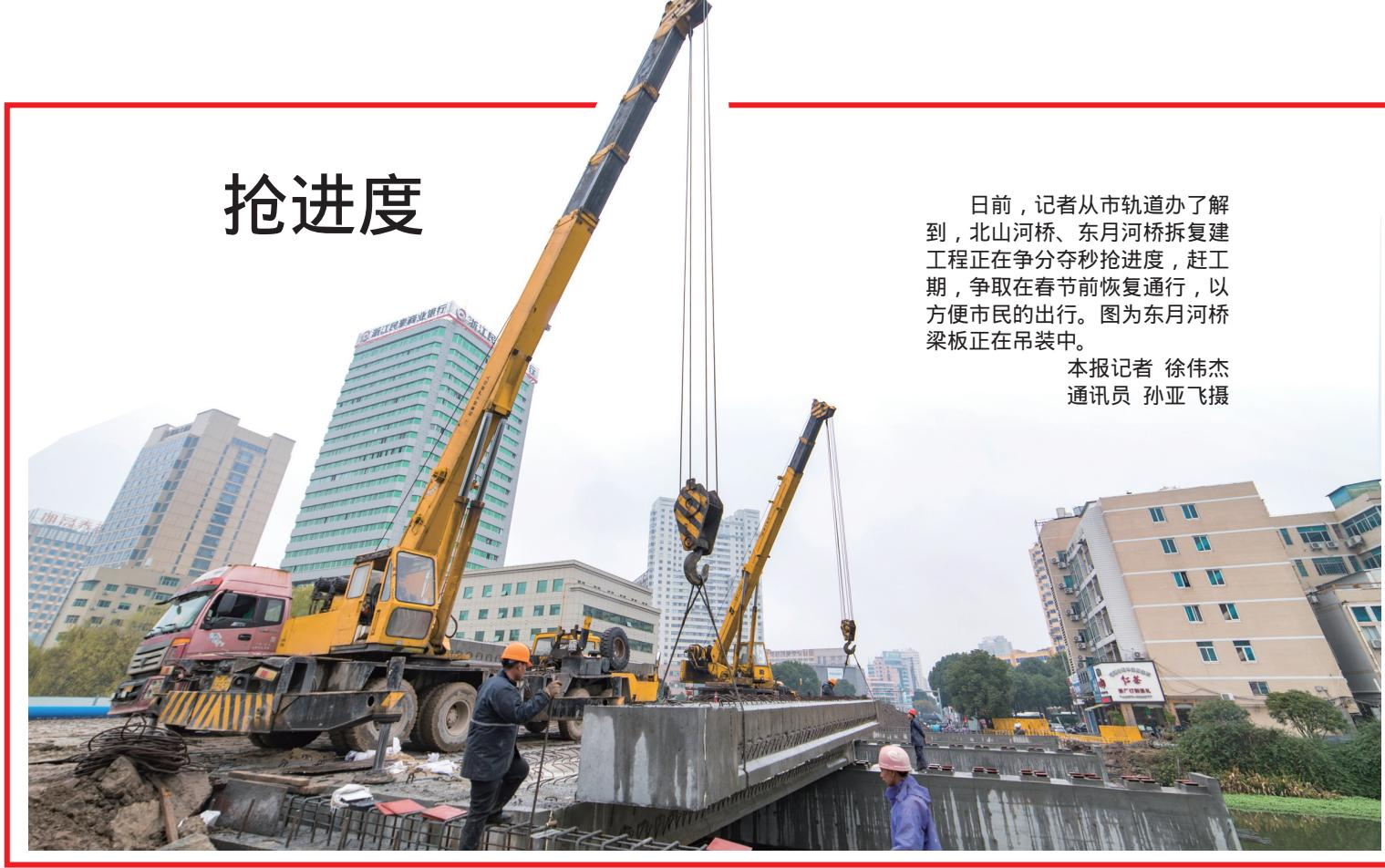
日前，记者从市轨道办了解到，北山河桥、东月河桥拆复建工程正在争分夺秒抢进度，赶工期，争取在春节前恢复通行，以方便市民的出行。图为东月河桥梁板正在吊装中。
