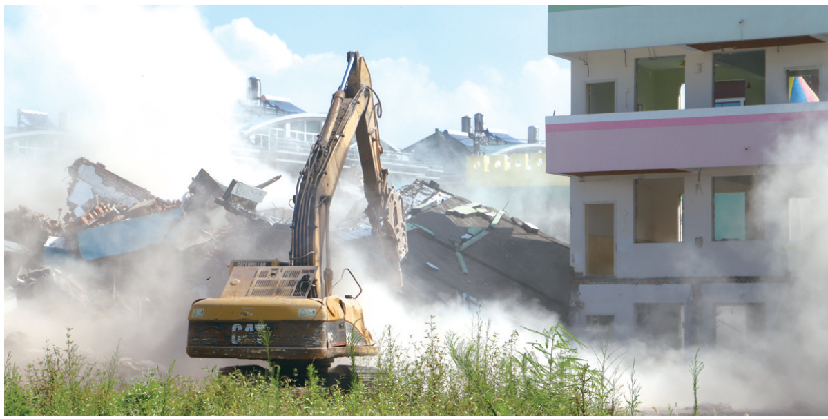
横峰中心幼儿园旧校区正在拆除。
