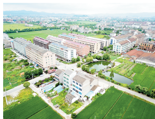
泵业智造小镇二期工程需向桥伍村征地300多亩。
