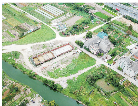
西桐村拆迁户已建好一层楼。
