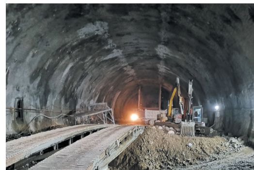
近期，楼山隧道内的施工现场。
