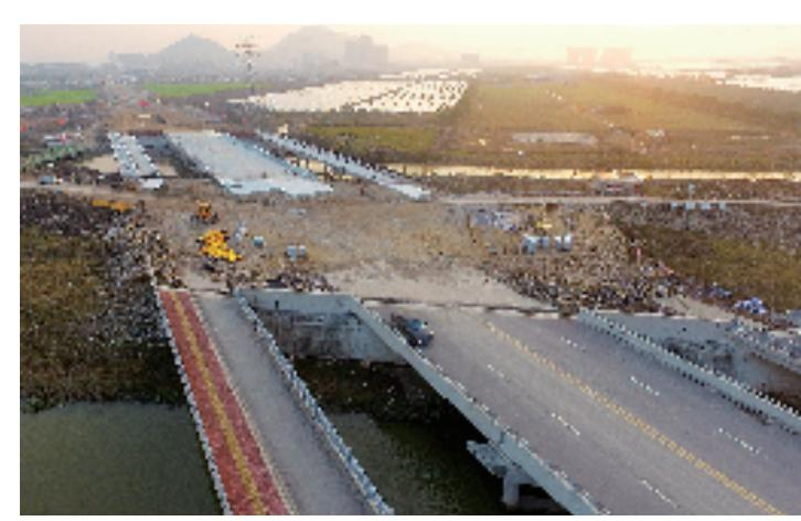
日前，金塘南路松门段市政一期工程的道路部分路基填筑已 完成，桥梁的基础部分也已经完成。
