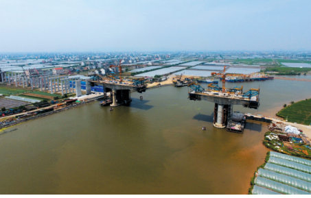
沿海高速金清港大桥逐渐合龙。 本报记者 庞辉斌摄
