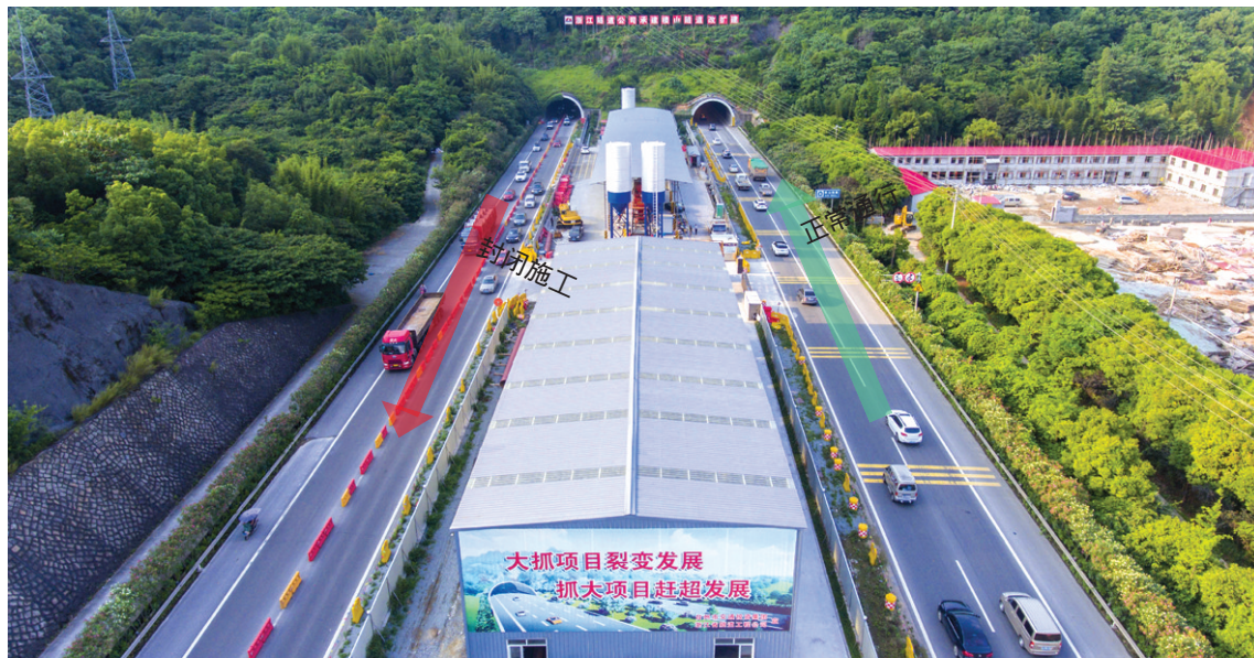
接下来，西侧隧洞将封闭施工，从路桥、椒江回温岭的驾驶员需提前绕道。
