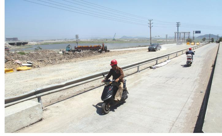
坦龙线龙门一号桥老桥改路工程已于7月下旬初步完工，进入了弯沉试验。这段时间，新造的道路可以临时通车了，但仅限小型车辆，大型车辆还得绕道老虎山。通过弯沉试验后，将会在上面铺浇上沥青，完全接通坦龙线。
