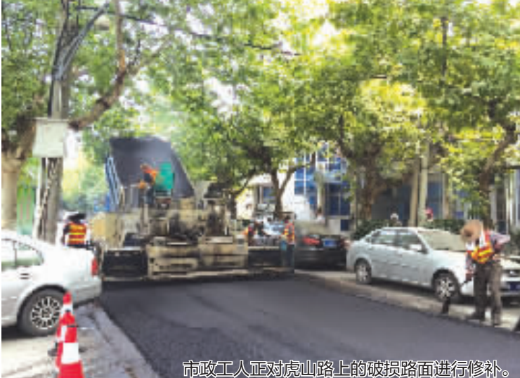
市政工人正对虎山路上的破损路面进行修补。
