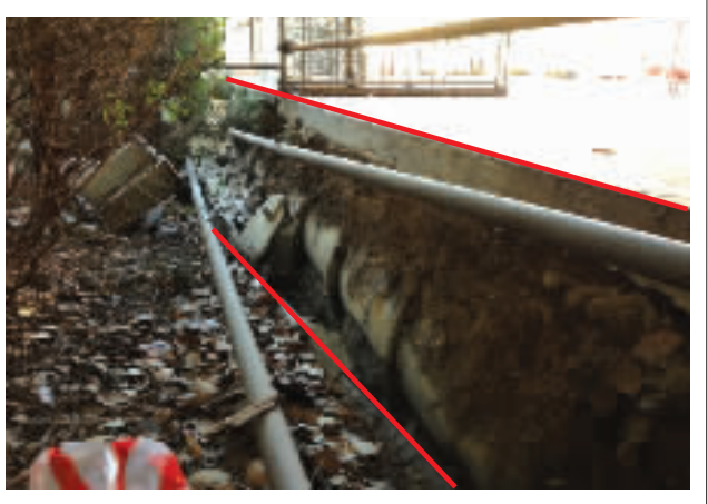
►图中红线标注即地面沉降后形成的落差。
