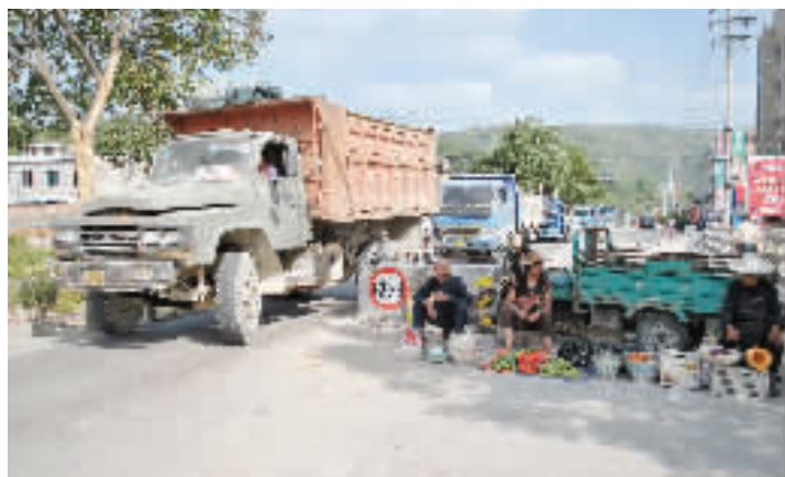
梅溪桥施工现场。本报通讯员 金云国摄
